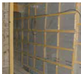
Isolation par soufflage
